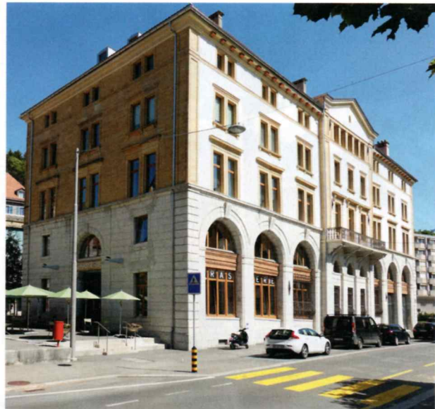
Die ehemalige Post von Le Locle ist aufwändig restauriert und trägt die Zeichen der Bodenabsenkung mit schrägen Fenstern.
