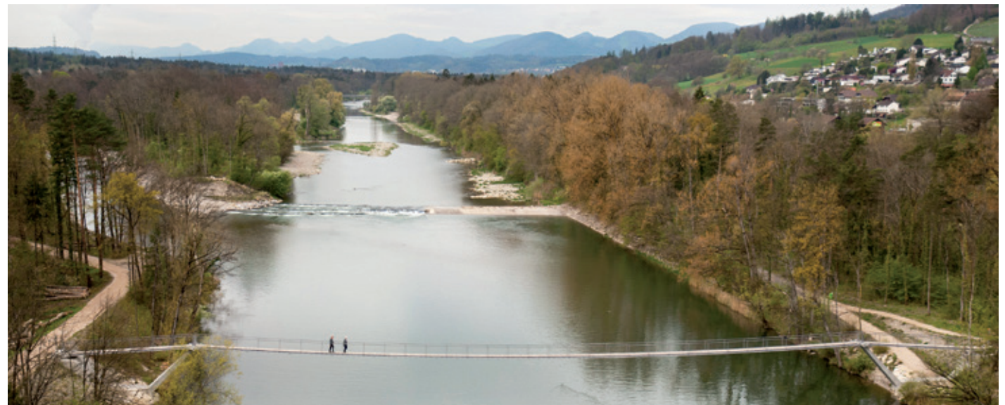
Dynamische Flussaue zwischen Rapperswil und Auenstein. Im Vordergrund ein neuer Fussgängersteg
