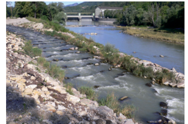
Fischaufstieg ins Verbindungsgewässer
